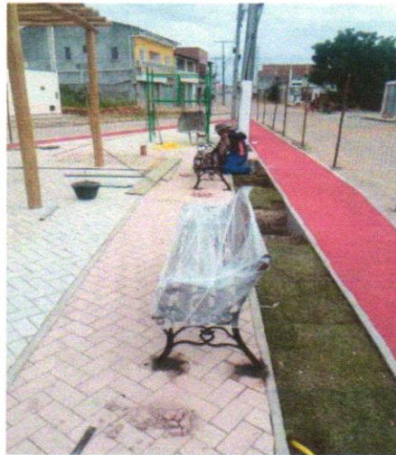
Foto 11 - Banco de madeira com encosto em eucalipto tratado (2,00X0,50)M
