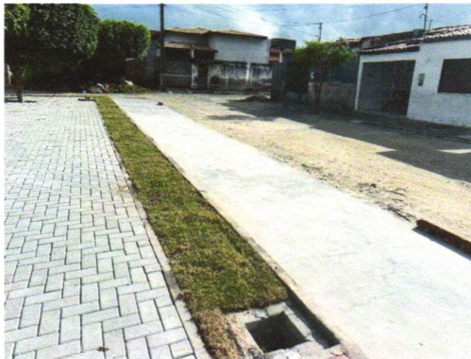
Foto 01 – PAVIMENTAÇÃO EM CONCRETO, COM ESPESSURA DE 7 CM, COM ACABAMENTO FEITO UTILIZANDO ALISADORA DE CONCRETO (HELICOPTERO), INCLUIDO TELA DE AÇO SOLDADA NERVURADA CA60, Q196 (3,11 KG/M2), DIAMETRO DO FIO 5.0 MM, LARGURA = 2,45 M, ESPAÇAMENTO DA MALHA = 10 X 10 CM, JUNTA DE DILATAÇÃO EM PVC A CADA 2,00 M, CONCRETO FCK = 20 MPA
